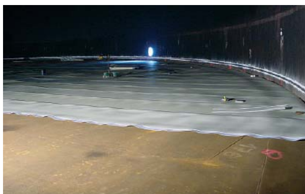
Установка проницаемого мата (спейсера)
