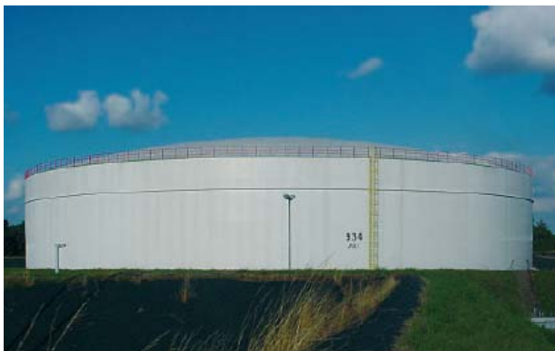
Общий вид резервуара
