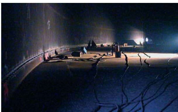
Установка системы крепежа вкладыша
