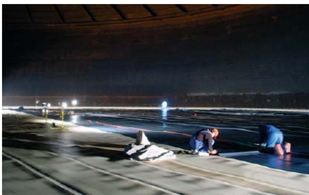
Установка эластичного вкладыша
