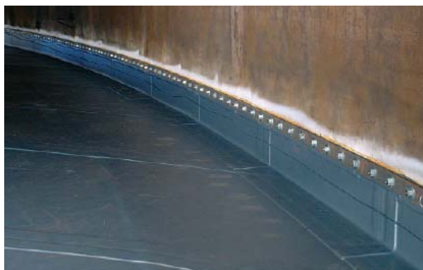
Вакуумный тест резервуара
