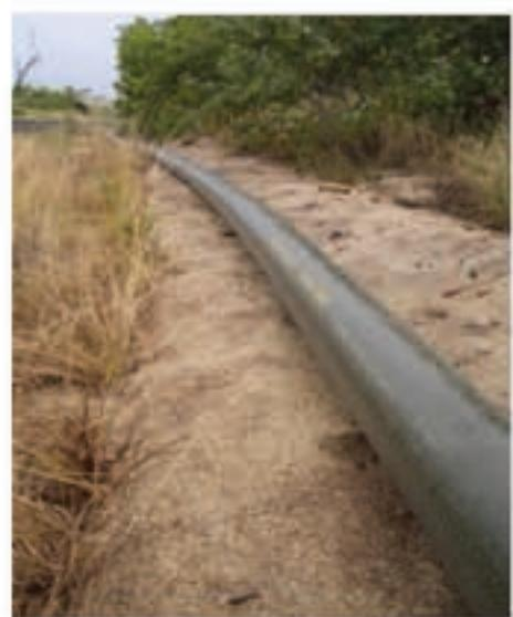
Полевые Магистральные Рукавные Трубопроводы серии ПМРТ предназначены для оперативной доставки нефти, нефтепродуктов, ГСМ, а также воды и технологических растворов на расстояние до 200 км и более по пересеченной местности.
