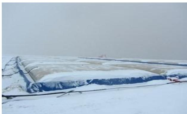
4.1.2. Полог обвалования ПФП (номинальный объем + 20%) и сборно-разборный каркас каре защитного обвалования;
