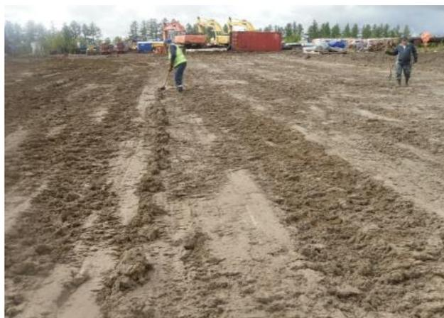
2.3. Для монтажа и оборудования ПСГ готовится ровная площадка. При отсутствии таких площадок, выравнивание осуществляется с помощью отсыпки грунтом, песком или песко-гравийной смесью (ПГС).
