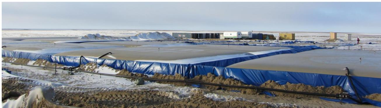
1.2. ПСГ общей вместимостью от 500 м<sup>3</sup> и более, комплектуются полимерными эластичными резервуарами серии ПЭР-125Н, ПЭР-250Н или ПЭР-300Н, номинальной вместимостью каждого 125, 250, 300 м<sup>3</sup> соответственно.
